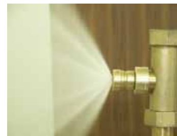
Wasser-Nebellöschanlage im Hochregallager
